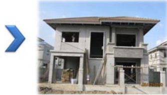
วันที่ 25-27 ฝังปูน ฝังท่อน้ำในชั้นล่าง วางพื้นผิวภายนอก
