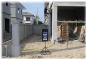
วันที่ 22-24 รั้วบ้าน กันซึม ก่ออิฐ และวางปูน (Pouring Duct)
