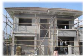
วันที่ 28-30 ฝังท่อน้ำในชั้นล่าง ฝังท่อน้ำในชั้นบน
